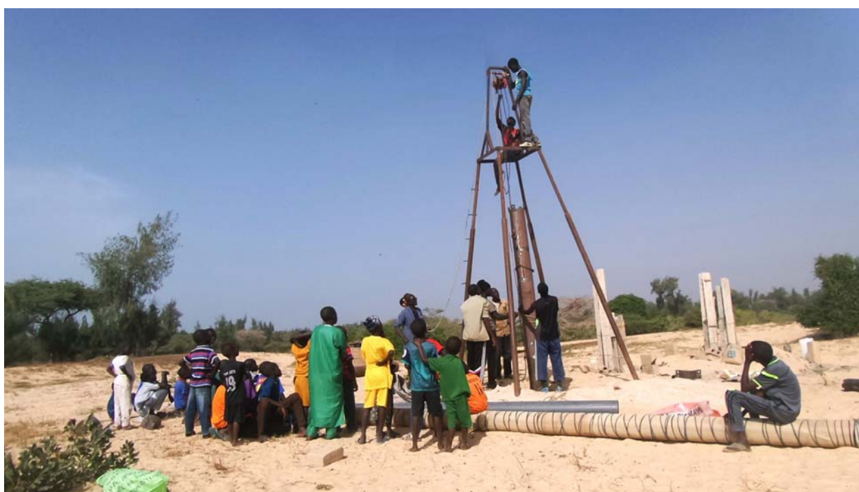
Figura 6: attività di perforazione
