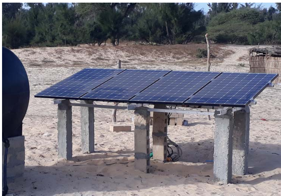
Figura 5: installazione pannelli solari
