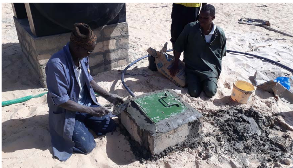
Figura 7: realizzazione pozzetto
