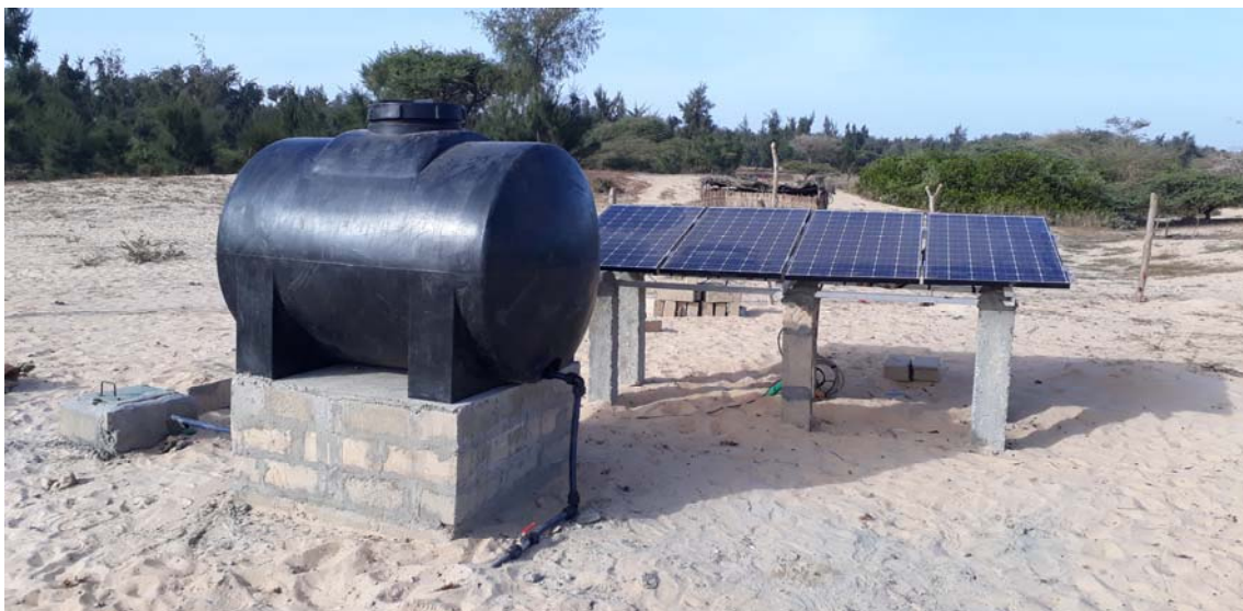
Figura 9: installazione e basamento cisterna di stoccaggio
